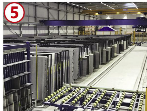
5 - AREA DI STOCCAGGIO 12 sistemi automatici di stoccaggio a fisarmonica. Capacità totale 5080 lastre (20 mm). 452 posizioni/prodotti diversi. 5 - STORAGE AREA 12X automatic concertina racking systems. Total capacity 5080 slabs (20mm). 452 different positions/products.
